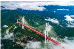
Es handelt sich um die weltweit erste Brücke mit einer Spannweite von einem Kilometer über eine Gebirgsschlucht. Die Hauptspannweite der Baling-Brücke ist eine 1088 Meter lange Stahlfachwerkträger-Hängebrücke mit einer Gesamtlänge von 2.237 Metern und einem Deck von 370 Metern über der Wasseroberfläche erstreckt.
